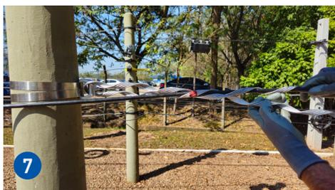
7 Faça coincidir a marca colorida da segunda perna da Alça Preformada com a da primeira e aplique-a sobre o cabo.
