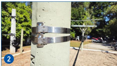
2 Instale as fitas de aço conforme ilustrado na foto.
