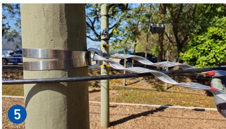
5 Tracione o cabo e a partir da marca colorida aplique uma das pernas da Alça Preformada sobre o cabo.
