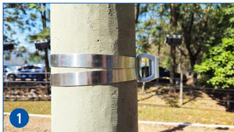
1 Instale o Suporte de Ancoragem SAM-01 utilizando duas fitas de aço no poste.
