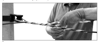
Traccione el cable y apartir de la marca de inicio de aplicación, aplique dos vueltas de una de las piemas de la Retención Preformada sobre el cable.
