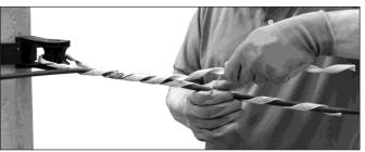
6. Haga coincidir la marca de color de la segunda pierna de la Retención Preformada con la primeray aplique dos vueltas sobre el cable. Intercale la instalación de las piernas aplicando de a tres vueltas por vez para evitar errores de instalación.
