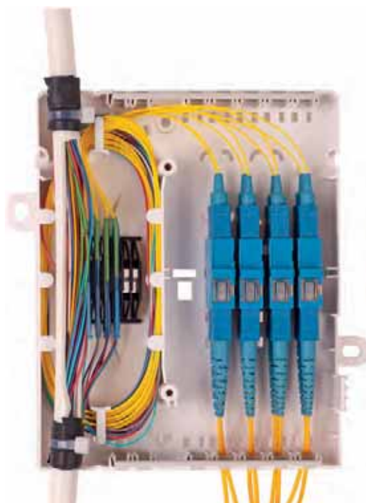
Aplicación con cable riser y terminación de 8 fibras
