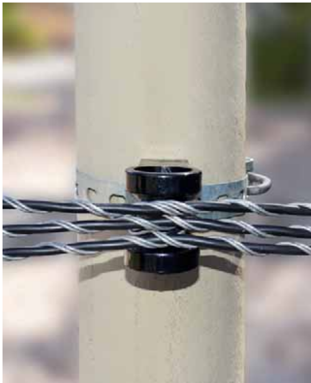
Suspensión con Ataduras Preformadas
