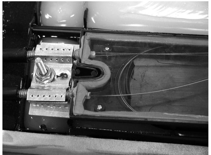
**FIGURA 7 - POSIÇÃO DA BANDEJA DE EMENDA SOBRE O BORNE EM FORMA DE V**
