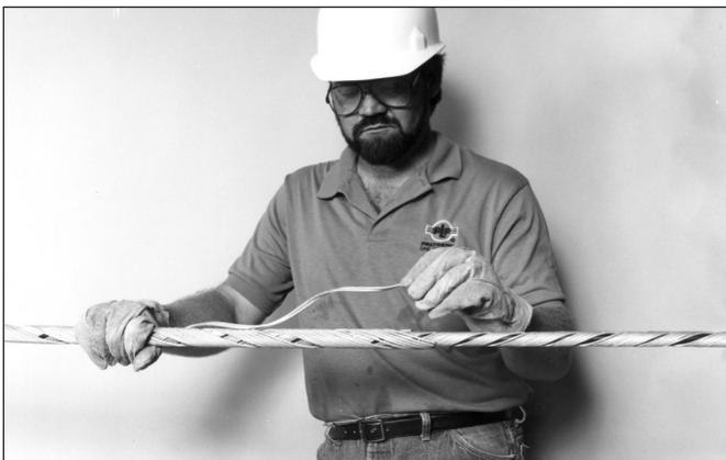
**Figura 10 - Separando las varillas de la pierna de la Retención Preformada.**
