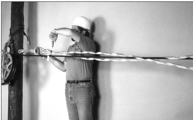
**Figura 2 - Posicionado de la Retención Preformada.**
