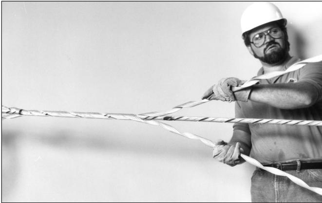
**Figura 9 - Envolviendo la Retención Preformada.**
