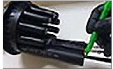
**9.** Deslizar el tubo hasta la base de entrada de la derivación y marcar el cable para la aplicación de la cinta adhesiva de aluminio.
