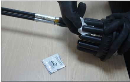
**7.** Limpiar la entrada de derivación con un paño humedecido en alcohol isopropílico.
