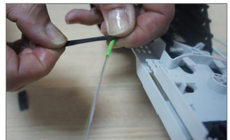
**15.** Hacer el acabado del tubo loose con la cinta autosoldable, entre la capa y la fibra óptica, manteniendo 10 mm sobre la fibra y 20 mm sobre el tubo loose.
