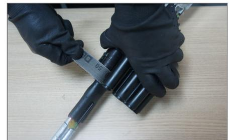
6. Lijar la superficie externa de la entrada de derivación, removiendo también la rebaba ocasionada por el proceso de apertura, posibilitando una mejor adherencia en el sellado con el tubo termocontraíble.
