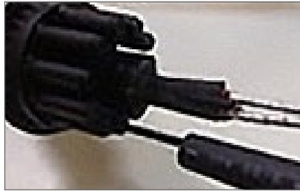
**8.** Introducir el cable óptico preparado por la entrada de la derivación.
