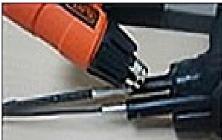
**13.** Reposicionar el tubo termocontraíble en la entrada de la derivación y con un soplador para alta temperatura, contraerlo hasta la desaparición de la pigmentación verde, para garantizar un buen sellado.
