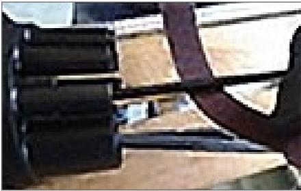
**10.** Lijar el cable hasta la marca, posibilitando una mejor adherencia en el sellado con el tubo y limpiarlo con un paño humedecido en alcohol isopropílico.
