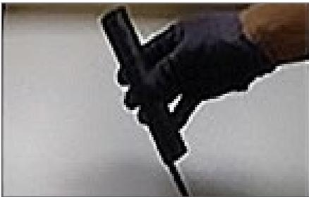
1. Antes de la preparación del cable óptico para derivación, introducirlo por el tubo termocontraíble.
