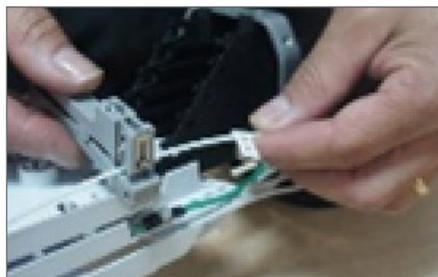
**14.** Identificar el tubo loose de la derivación con la etiqueta apropiada y cortar con el rodillo.
