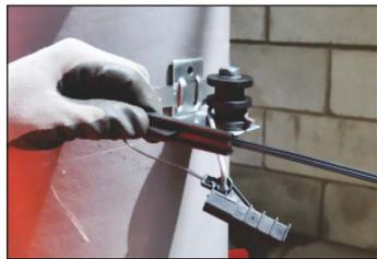
5.1. Fijar el gancho del SRDO en la roldana RP-2, luego estirar el drop hasta el punto de fijación y colocar el NÚCLEO del SRDO en este punto, asegurándolo junto con el drop.
