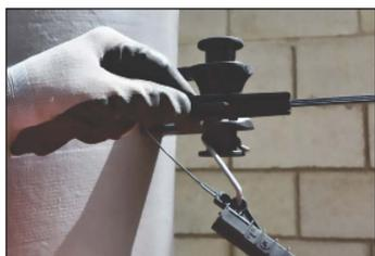
4.1. Fijar el gancho del SRDO en la roldana en el SCO, luego estirar el drop hasta el punto de fijación y colocar el NÚCLEO del SRDO en este punto, asegurándolo junto con el drop.
