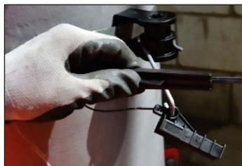
3.1. Fijar el gancho del SRDO en el SDA, enseguida estirar el drop hasta el punto de fijación y colocar el NÚCLEO del SRDO en este punto, asegurándolo junto con el drop.
