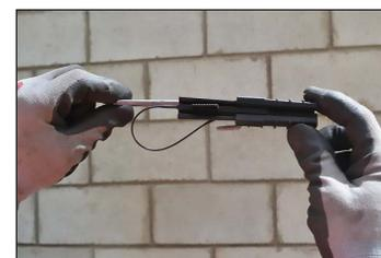
2.2 En la instalación del drop, acomodar primero el NÚCLEO en el drop y enseguida el CUERPO, deslizando el CUERPO en el sentido del NÚCLEO.
