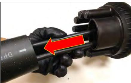
4.10. Deslizar el tubo termocontraíble hacia afuera de la entrada ovalada, sobrepasando la marca anteriormente realizada.
