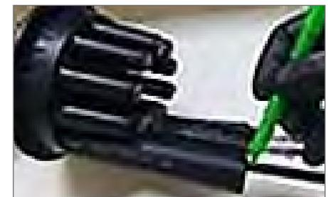
**6.9.** Deslizar el tubo hasta la base de entrada de la derivación y marcar el cable para la aplicación de la cinta adhesiva de aluminio.
