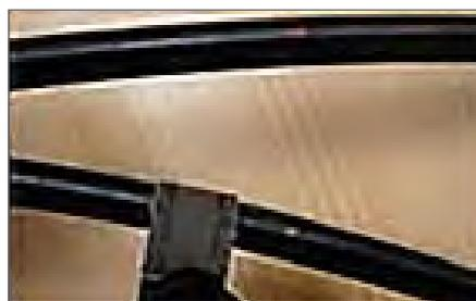
4.11. Lijar el cable hasta la marca, posibilitando una mejor adherencia en el sellado con el tubo termocontraíble y limpiar con un paño humedecido en alcohol isopropílico.
