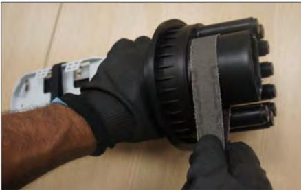
4.4. Hacer la apertura de la entrada ovalada con la herramienta adecuada y lijar la superficie externa de esa entrada, removiendo también la rebaba ocasionada por el proceso de apertura, posibilitando una mejor adherencia en el sellado con el tubo termocontraíble.
