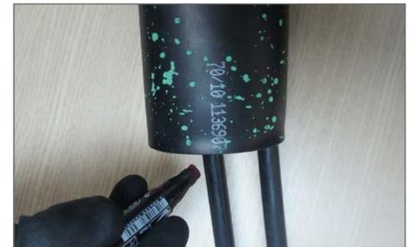
4.9. Marcar el cable para la colocación de las cintas adhesivas de aluminio.
