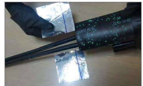
4.12. Posicionar la cinta adhesiva de aluminio, manteniendo alineada la línea azul presente en ella (aprox. 25 mm del borde de la cinta) con la marca realizada en el cable óptico, siendo que la menor parte estará en el sentido de la caja.
