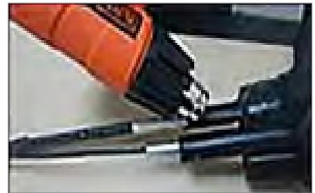
**6.12.** Reposicionar el tubo termocontraíble en la entrada de la derivación y con un soplador para alta temperatura, contraerlo hasta la desaparición de la pigmentación verde, para garantizar un buen sellado.
