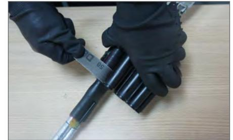
**6.6.** Lijar la superficie externa de la entrada de derivación, removiendo también la rebaba ocasionada por el proceso de apertura, posibilitando una mejor adherencia en el sellado con el tubo termocontraíble. Limpiar la entrada de derivación con un paño humedecido en alcohol isopropílico.
