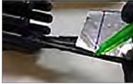
**6.11.** Colocar la cinta adhesiva de aluminio, manteniendo alineada la cinta azul presente en ella (aprox. 25 mm del borde de la cinta) con la marca realizada en el cable óptico, siendo que la menor parte estará en el sentido de la caja.
