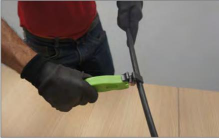
4.1. Abrir el cable con el rodillo pelacables, hacer un corte de 1,4 m y prepararlo.
