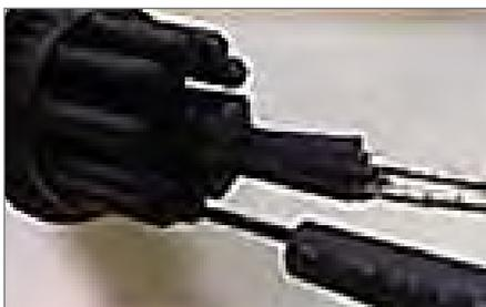
**6.7.** Introducir el cable óptico preparado por la entrada de la derivación.
