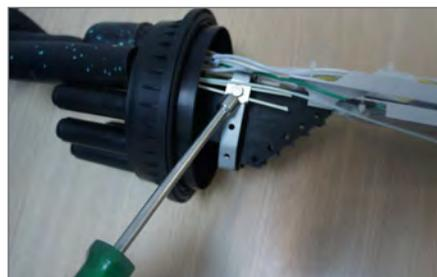
**6.8.** Posicionar el cable de derivación para la retención del elemento de tracción y trabarlo.
