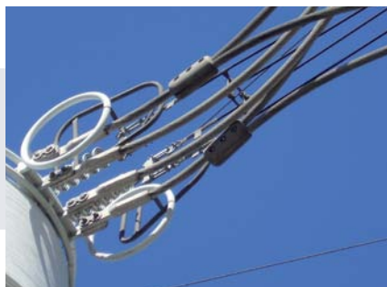
Conectores Paralelos Abulonados
