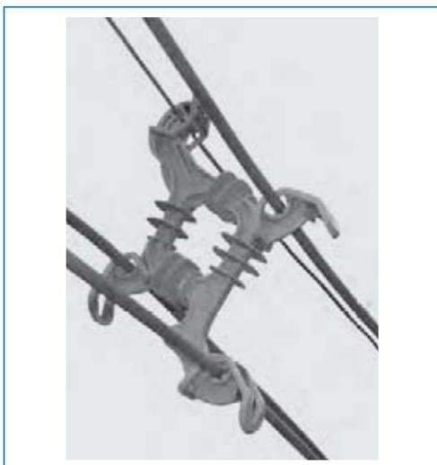
El Espaciador Poligonal con Garras es utilizado en redes de distribución aérea, clase de tensión 15 KV, en cables protegidos.
