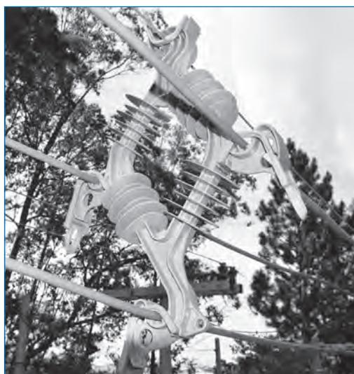
El Espaciador Poligonal con Garras es utilizado en redes de distribución aérea, clase de tensión 35 KV, en cables protegidos.
