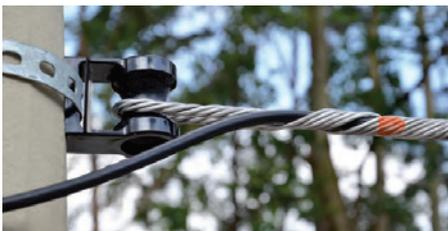
Desenvolvida especialmente para a ancoragem dos cabos ópticos dielétricos aéreos autossustentados em pequenos vãos de 80 a 200 metros, a Alça Preformada Fiberlign® Loop Longo – OPDE é aplicada diretamente sobre a cobertura do cabo, e tem como função receber e distribuir os esforços sem provocar danos à capa do cabo ou às fibras ópticas, garantindo assim sua integridade mecânica e estrutural.
