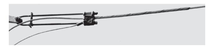
Proyectada especialmente para garantizar un elevado agarre al cable OPGW, sin riesgos de compresión de las fibras ópticas y para las condiciones de vibraciones más severas y esfuerzos dinámicos.
