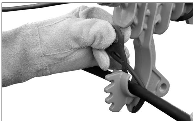
**2.4** Aplique o Anel no condutor inferior e, em seguida, nos outros condutores, conforme item 1.3.
