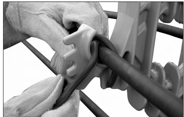
**1.4** Aplique o Anel no condutor inferior e, em seguida, nos outros condutores.
