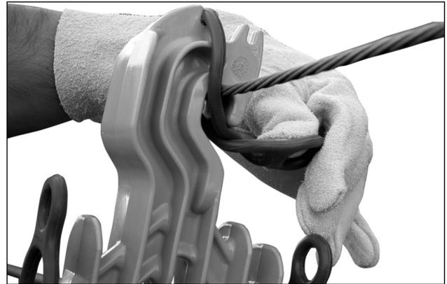
**1.3** Iniciando a aplicação pelo cabo mensageiro, dê um giro no Anel, estique e posicione a sua extremidade na ranhura localizada na garra do Espaçador.
